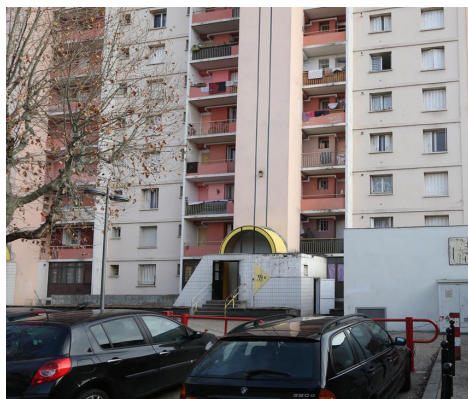
Façade de la grande barre de la résidence Le Pranard © Ville de Villeurbanne
